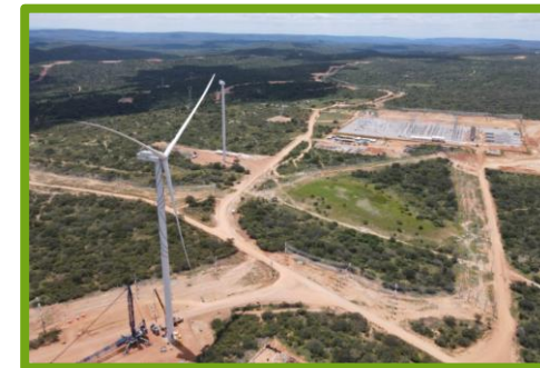
FOTO: Montagem aerogerador OITIS 05 com SE ao fundo
