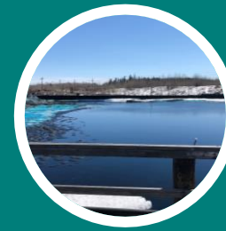
Armazenado em áreas de contenção projetadas
