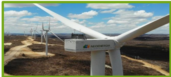
FOTO: Complexo Chafariz
